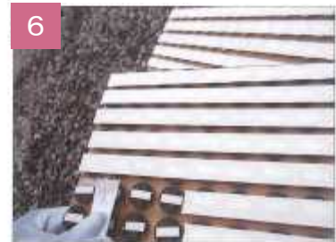
6 専用取付具の両面テープのない箇所に接着剤を塗布します。
