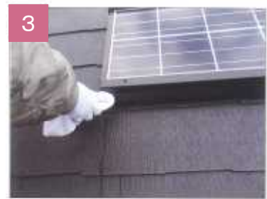
3 専用取付具の取り付け箇所を雑巾で拭き取ります。
