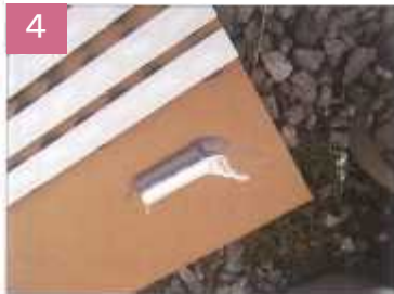
4 同量のA剤B剤を作業用貼付けボードの空いている箇所に出します。
