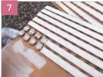
7 一度に多くを練り混ぜると硬化が早い(5分程)ので、作業にあわせて練り混ぜてください。
