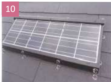
10 30cm間隔で作業を繰り返し全てに専用取付具を設置します。
