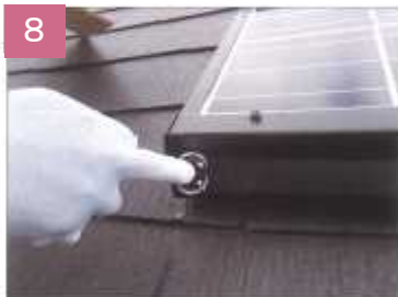
8 専用取付具のフックが平行になるように取り付けます。
