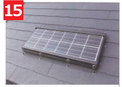
15 最後に目視点検を行い、施工完了です。
