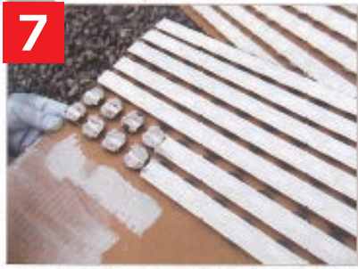
7 一度に多くを練り混ぜると硬化が早い(5分程度)ので作業にあわせて練り混ぜてください。
