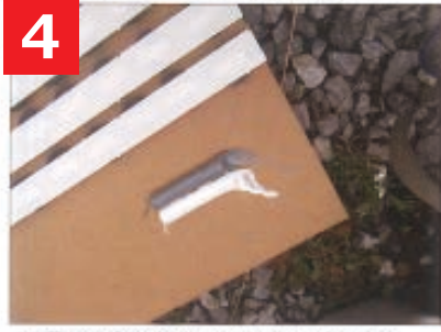
4 同量のA剤B剤を作業用貼付けボードの空いている箇所に塗布します。
