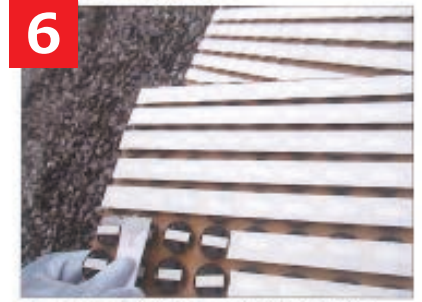
6 専用取付具の両面テープのない箇所に接着剤を塗布します。
