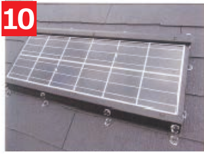
10 30cm 間隔で作業を繰り返し全てに専用取付具を設置します。
