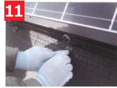
11 接着剤の硬化確認後、ネットの端から1目を残し、取付具のフックに引っ掛けます。
