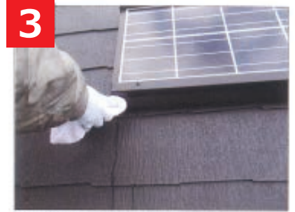
3 専用取付具の取り付け箇所の汚れを雑巾で拭き取ります。
