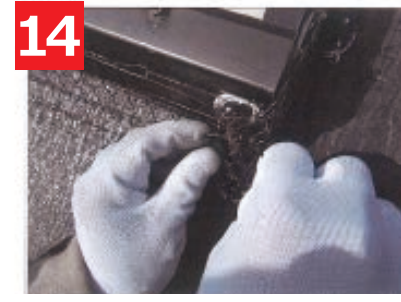
14 同封のつなぎ用ロープで、ネットとネットをつないでください。
