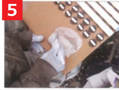
5 接着剤と同封されたヘラで薄いグレー色になるよう、しっかりと混ぜます。
