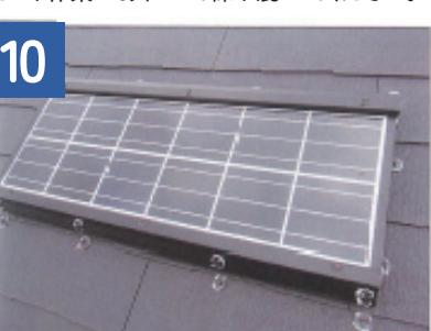
30cm 間隔で作業を繰り返し全てに専用取付具を設置します。
