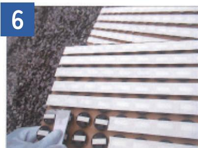
専用取付具の両面テープのない箇所に接着剤を塗布します。
