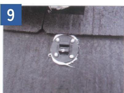
設置した際に専用取付具の4つの穴から接着剤がでればOKです。
