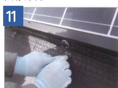
接着剤の硬化確認後、ネットの端から1目を残し、取付具のフックに引っ掛けます。
