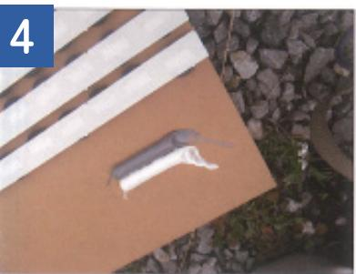
同量のA剤B剤を作業用貼付けボードの空いている箇所に出します。
