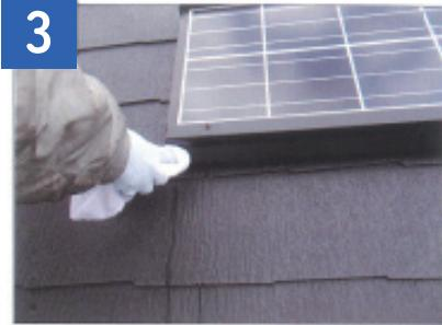
専用取付具の取り付け箇所の汚れを雑巾で拭き取ります。
