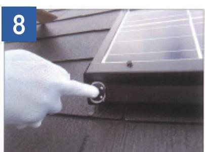
専用取付具のフックが平行になるように取り付けます。
